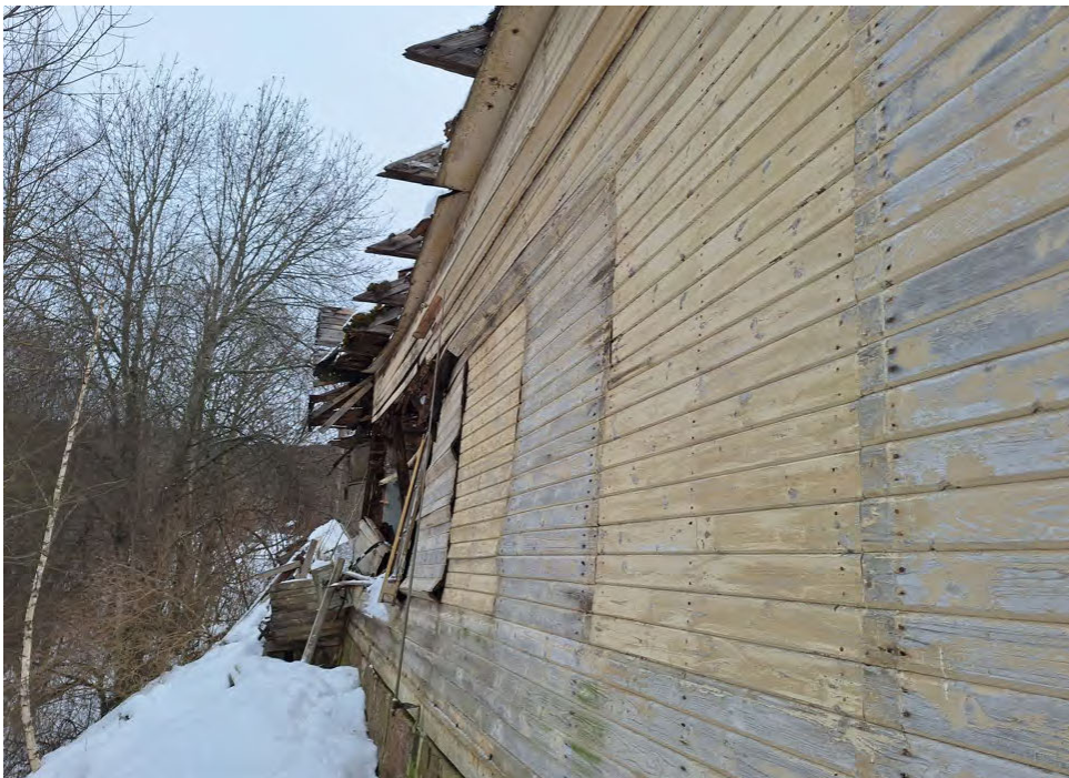
Bild 4. Byggnadens norra fasad
