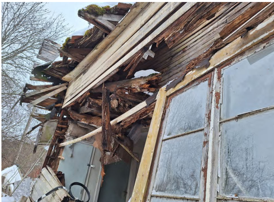
Bild 5. Byggnadens nordöstra hörn. Väggen har rasat in och den bärande takkonstruktionen håller sakta men säkert på att kollapsa.
