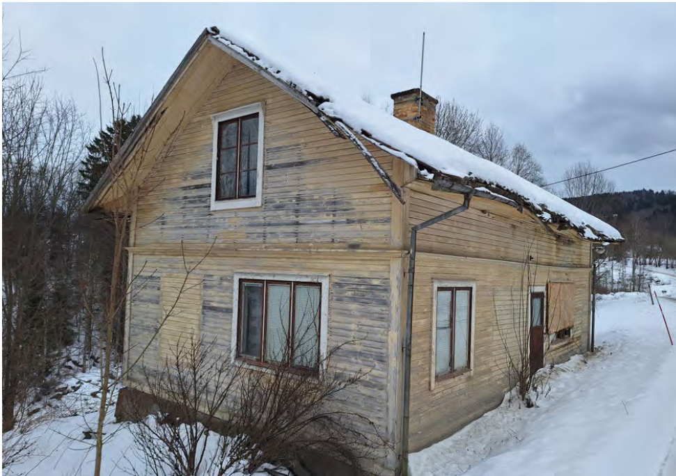
Bild 3. Byggnadens västra fasad
