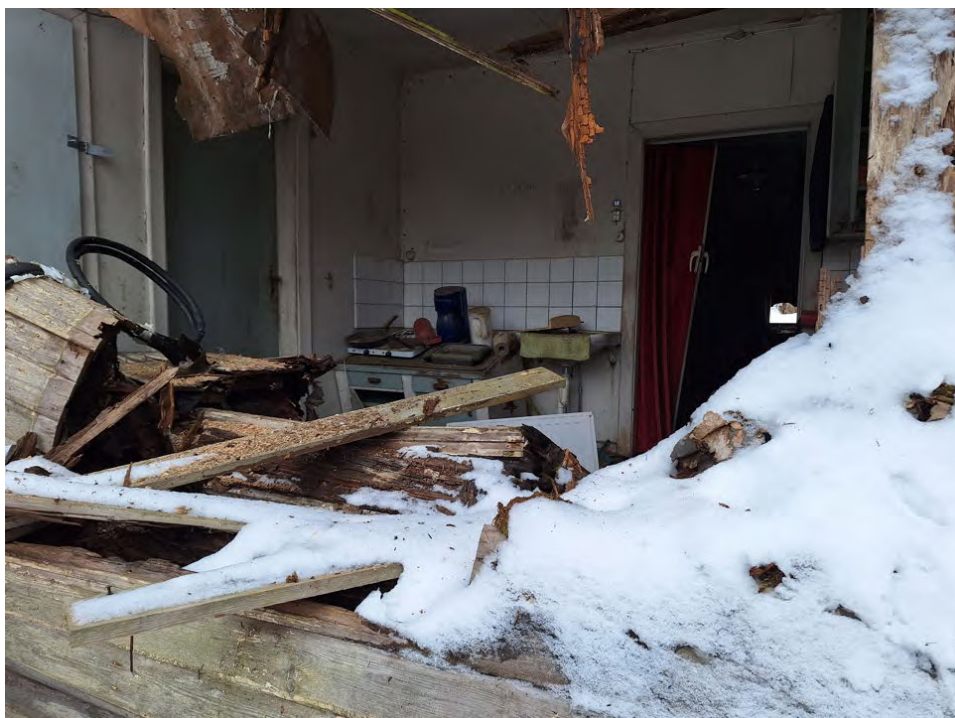
Bild 6. Det tidigare köket bakom byggnadens norra fasad
