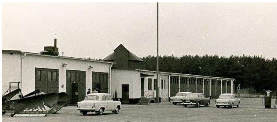
Vägverkets gamla vägstationen i Brösarp, troligen första halvan av 60-talet.
