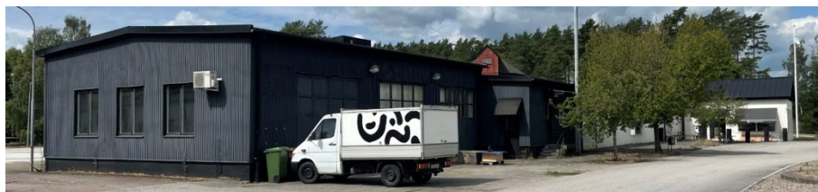
Centralt i området ligger byggnader för Österlenbryggarna, sett från nordost. Väster om bryggeriet finns en gammal sandsilo som idag är ur bruk.
