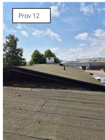
Figur 15. Fog och papp på tak. Innehåller ej asbest och låga halter av PAH (ej tjärpapp).
