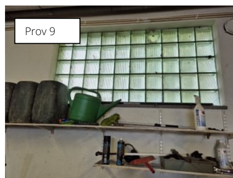
Figur 13. Fönsterkitt kring betongglaset. Innehåller ej asbest.
