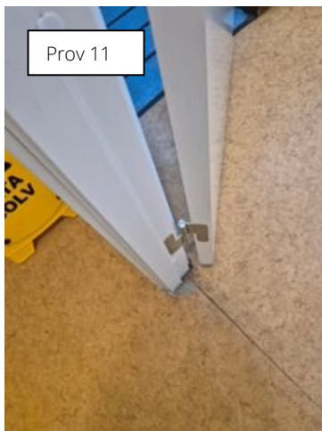
Figur 14. PVC-matta i förråd. Innehåller ej asbest.
