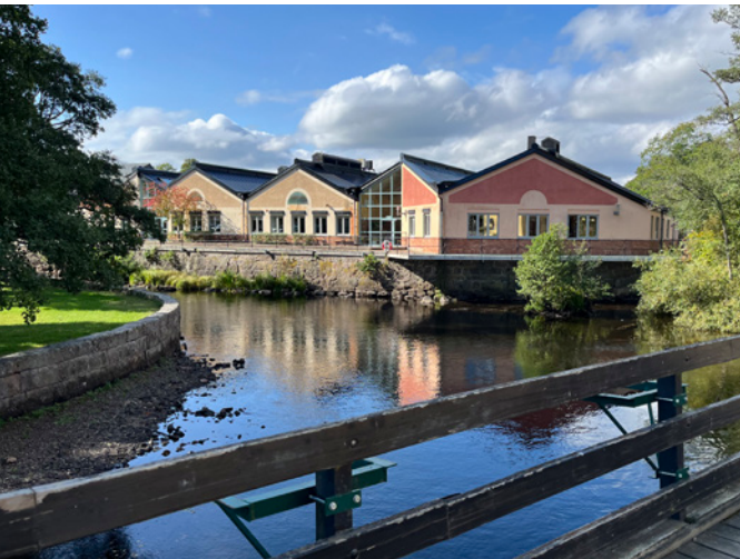
Träbron som ugör den f.d. järnvägsbron utgör ett viktigt gångstråk och ger vyer över den samlade industribebyggelsen.
