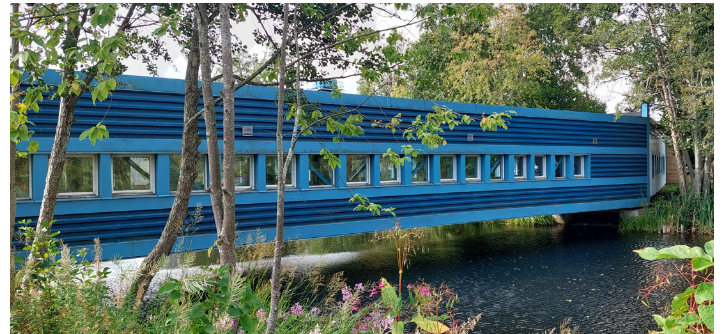
Foto befintlig bro vid Solviks äldreboende.
