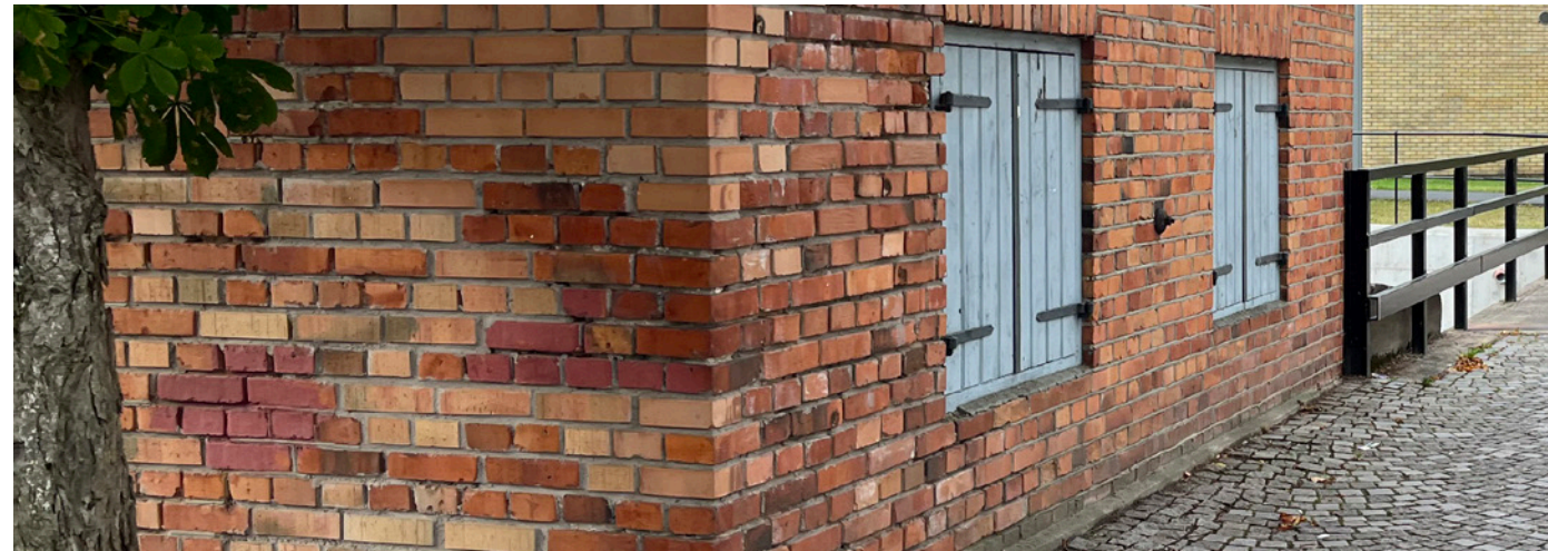
Robust tegelarkitektur och gatstensbeläggning är värdebärande karaktärsdrag inom den äldre industrimiljön på Vulcanön.
