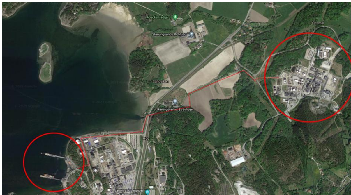
Figur D4. Rörgata mellan Perstorp Oxo AB och Petroport/ Vattenfalls hamn.
