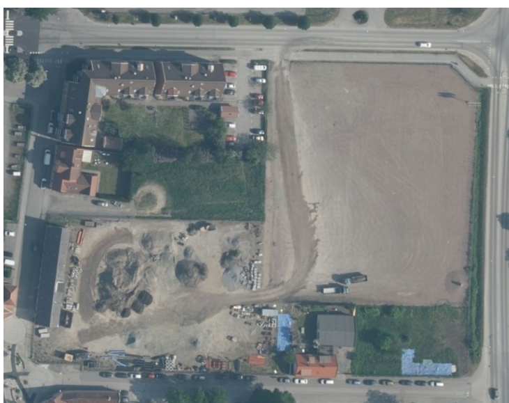
Figur 8: planområdet efter genomförd sanering
