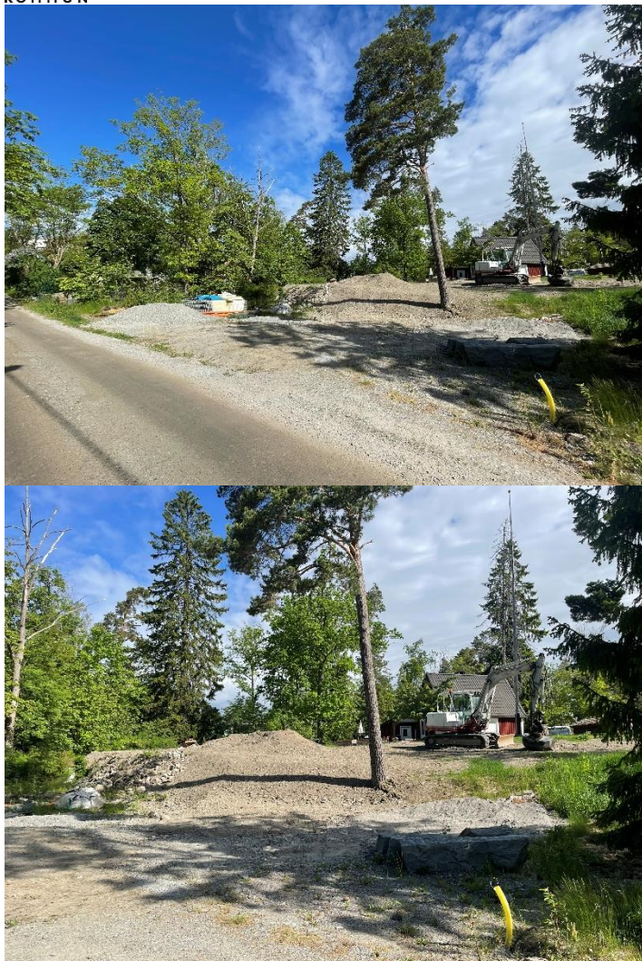
Bild 17-18. Vissa delar av massorna hade flyttats till område där det finns ett startbesked för attefallshus och ett utgången lov för markförändringar.
