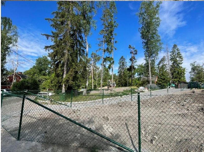
Bild 14-16. Foton av område med nytt staket och nya upplagda massor på delen av fastigheten.
