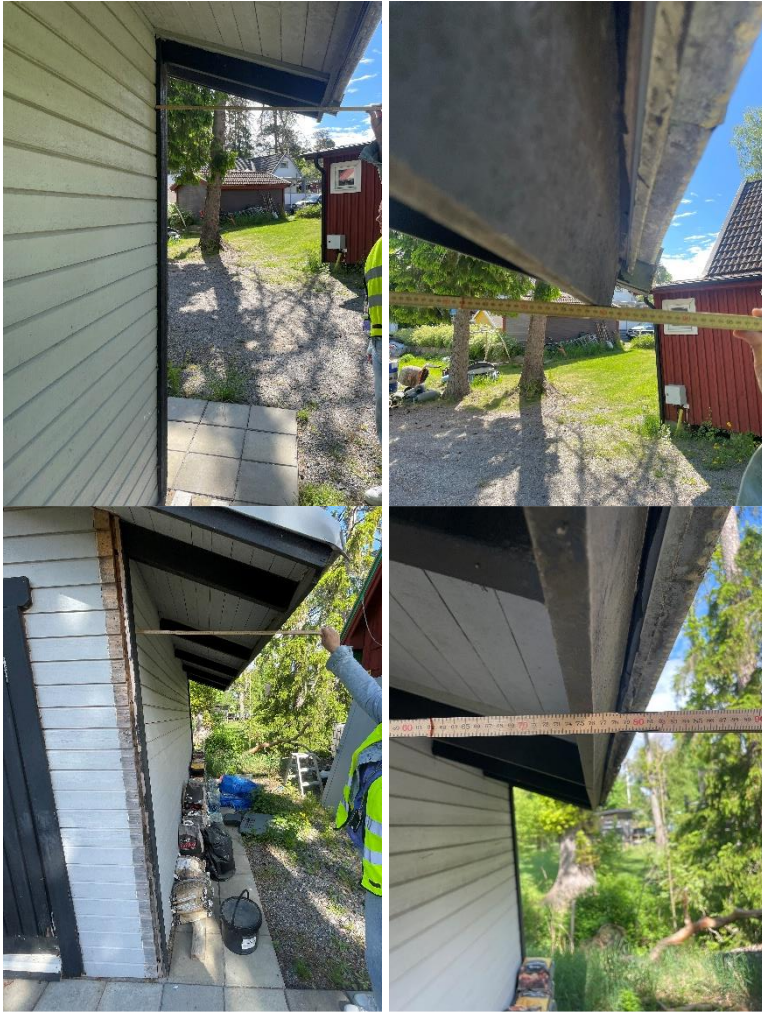
Bild 6-9. Foton av mätning på utskjutande takparti längs byggnadens långsidor. Mätt till liggande takfotsbrädas ytterkant uppmättes 76 och 79 cm på respektive sida.
