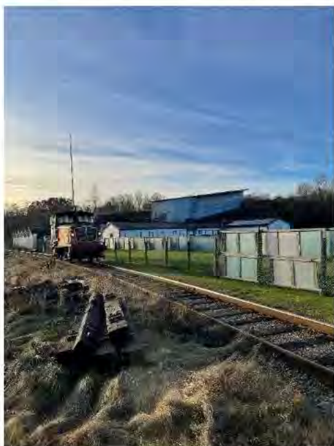
Figur 18. Lokalt järnvägsspår vid idrottsområde.
