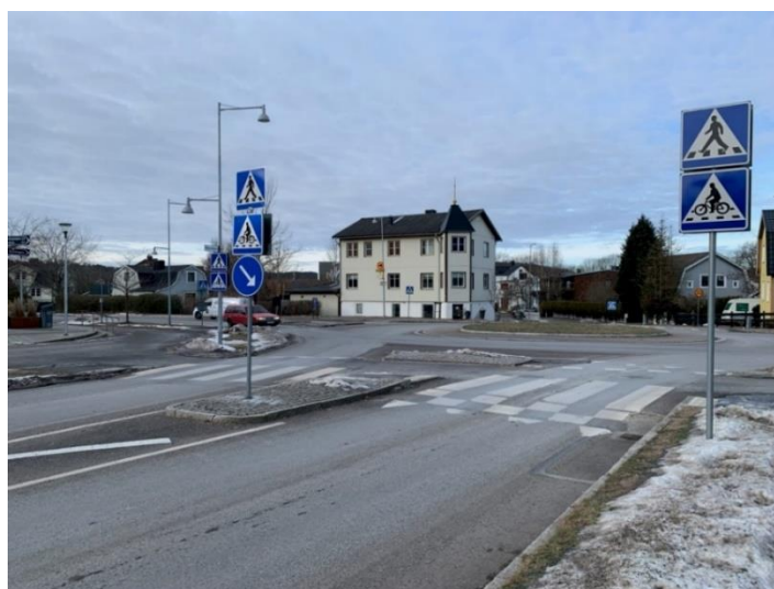
Figur 6: Nyanlagd hastighetsdämpad cykelöverfart och övergångsställe över Åbyvägen.
