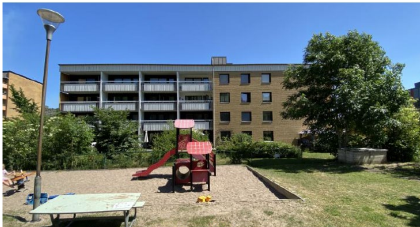
Fasad åt väster på Gustavsbergsgatan 7-13 med balkonger.
