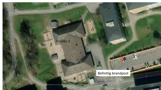
Placering av befintlig brandpost markerats ut, söder om förskolan.
