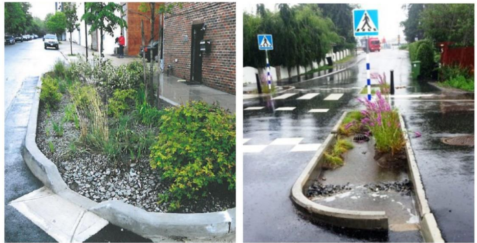
Figur 14. Exempel på regnbädd. Till vänster: det är viktigt att inloppet placeras på rätt nivå så att avrinning från ytor kan enkelt komma in i anläggningen. Till höger: Viktigt att tänka på är att strax vid inloppet behövs erosionsskydd (till exempel ett lager med makadam) att finnas så att fillermaterialet förhindras från att spolats ut vid höga flöden. (Godecke-Tobias Blecken 2016)
