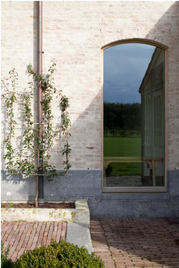
Den befintliga byggnaden från 90-talet föreslås få ett nytt uttryck genom att slamma teglet.
