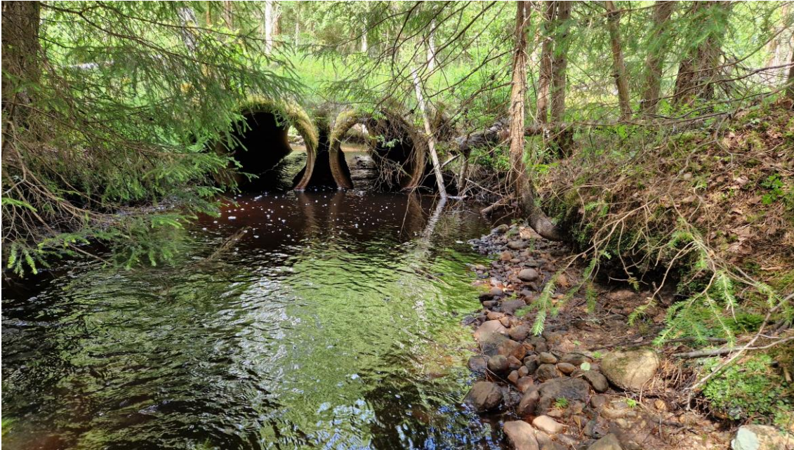
Figur 38. Älgabäckens flöde genom dubbeltrumma som utgör bestämmande sektion för vattendragets nivå. Vid breddning av väg och byte av vägtrumma får bottenytan i vattendraget inte förändras i läge eller bredd på ett sådant vis att det ökar markavvattningen.
