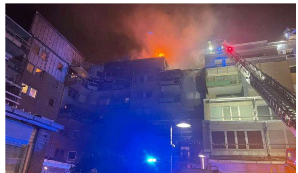
Vindsbrand i flerbostadshus. Foto: RSG
