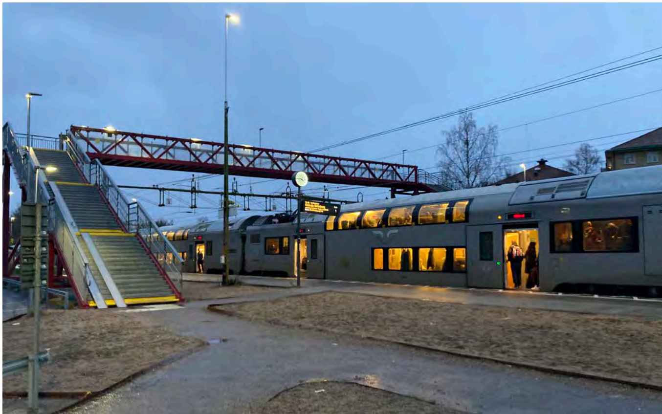
Bild 1. Miljön intill perrongerna präglas av asfaltsytor och andra hårdgjorda sidoytor intill Trafikverkets broförbindelse.
