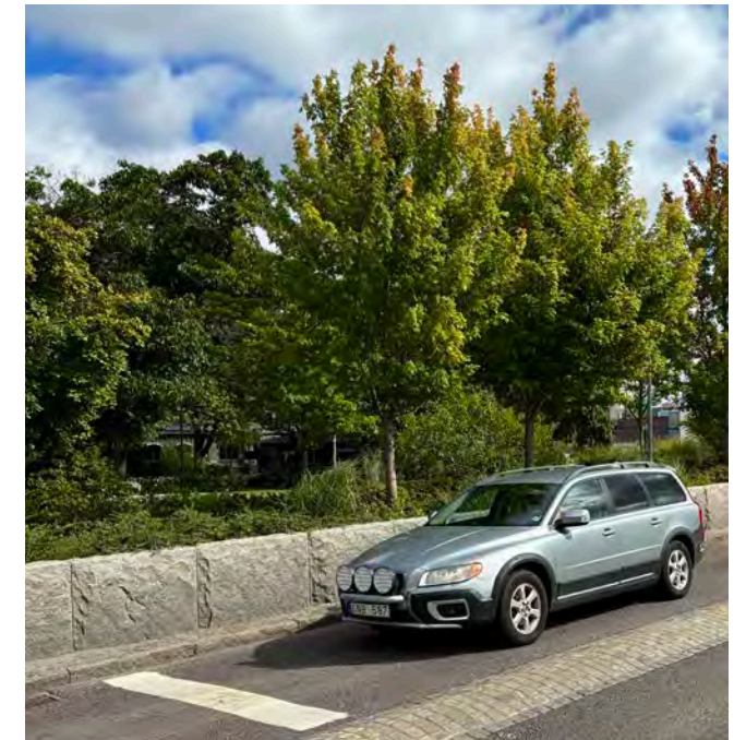
Bild 4. Referens lite grövre blockstensmur i kant mot trafikerad gata som gräns och bullerdämpning.
