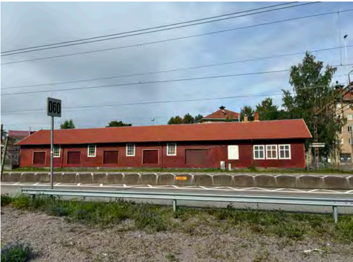
2. Godsmagasinet med skjutdörrar.
