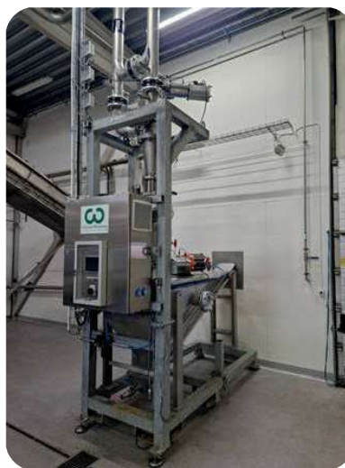
Installation av en cyklon pågår på Hulesjöns biogasanläggning. Cyklonen kommer att rena slurryn från traktioner såsom sand, grus och sten.
