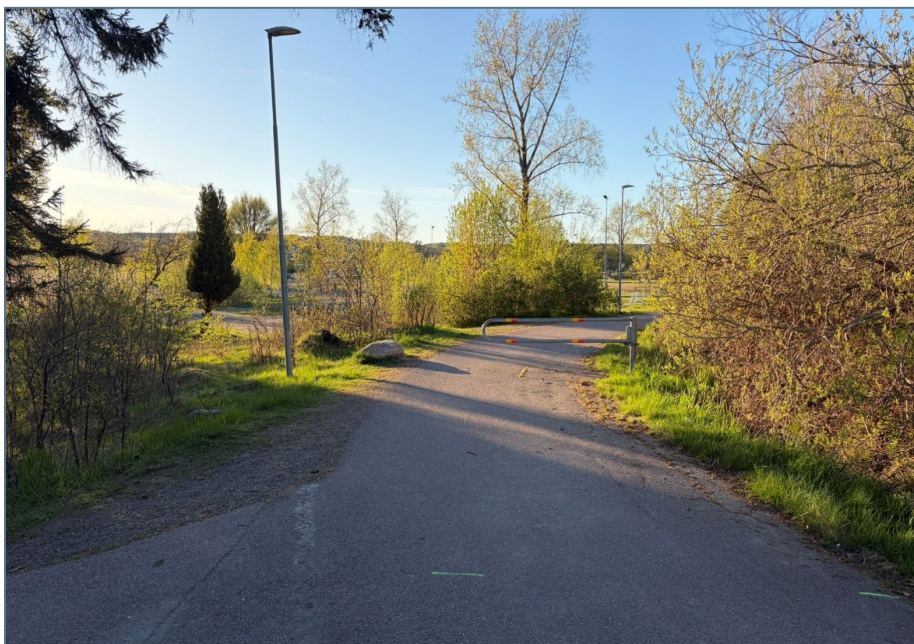
Figur 5. Belysningsstolpar på västra sidan av GC-väg mellan Gamla Kilandavägen och Fyrklövergatan. Foto taget i nordvästlig riktning.
